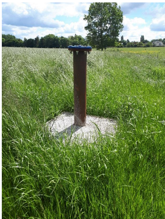
Vue sur le piézomètre aux alluvions
